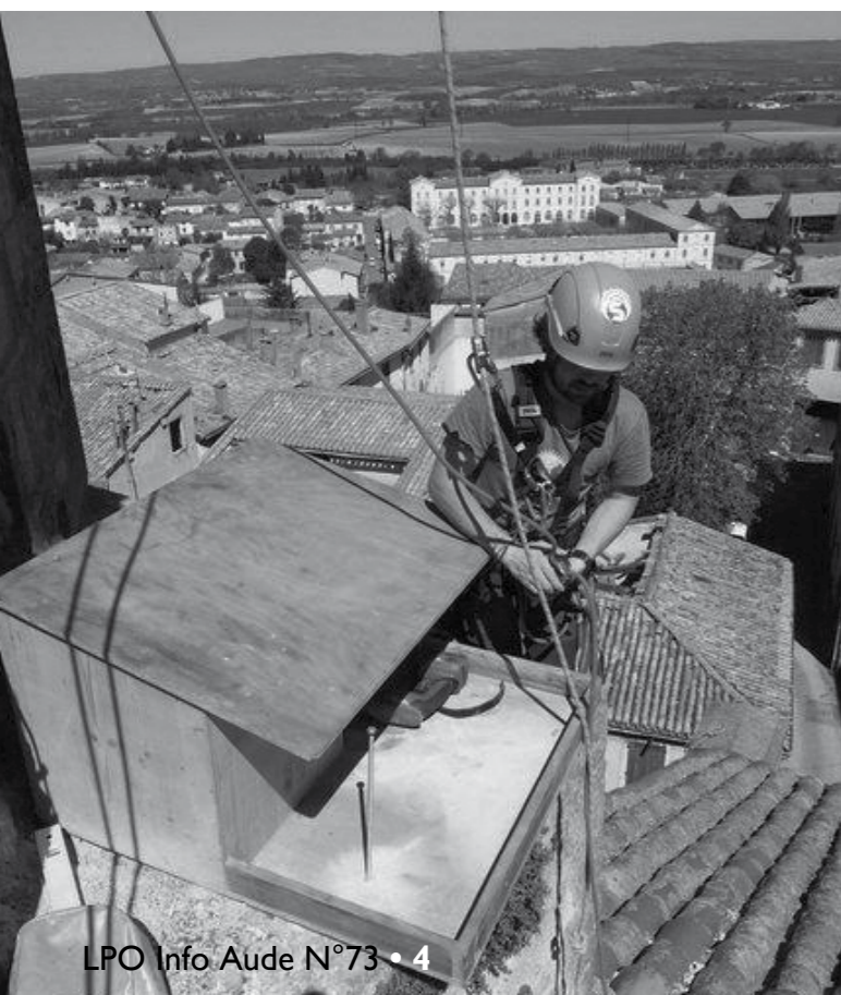
Installation de la plateforme à Faucon pèlerin sur le clocher de la Collégiale de Castelnaudary © LPO Aude
